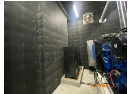
ผนังห้องห่อแปลงเป็นแบบกันเสียง
