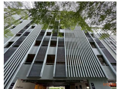
ช่องระบายอากาศอาคารจอดรถ
